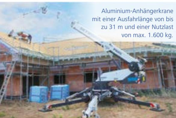
Aluminium-Anhängerkrane mit einer Ausfahrlänge von bis zu 31 m und einer Nutzlast von max. 1.600 kg.
